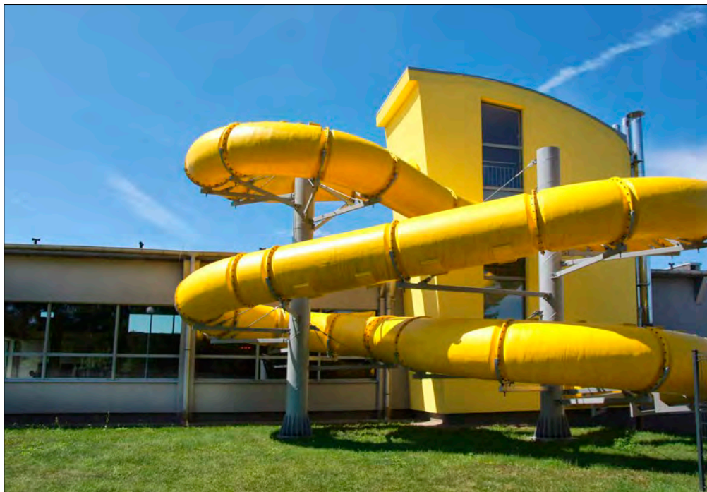
Termomodernizacja Pływalni Oceanik
