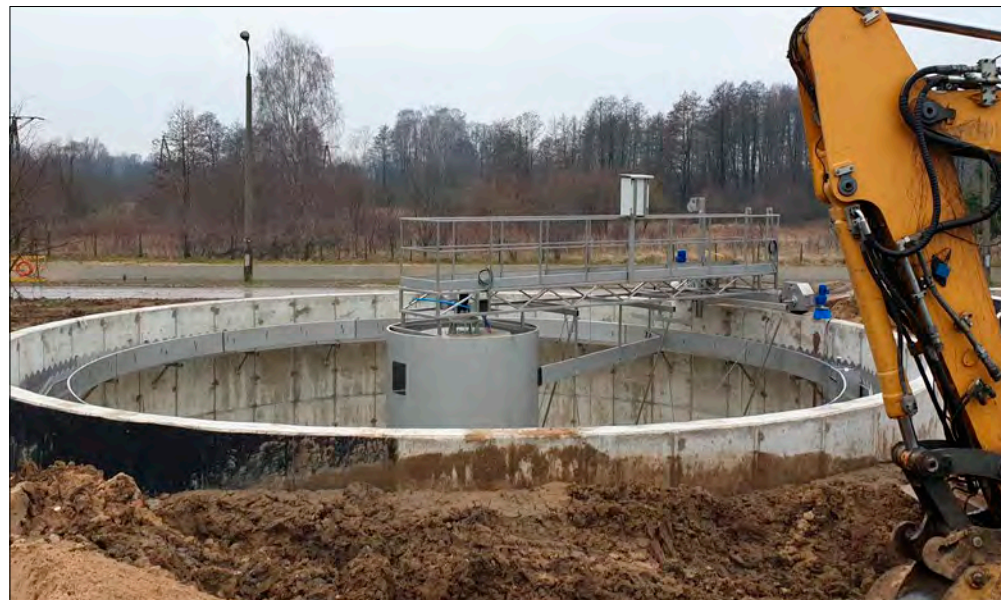
5: Modernizacja Oczyszczalni Ścieków w Tuszynie
