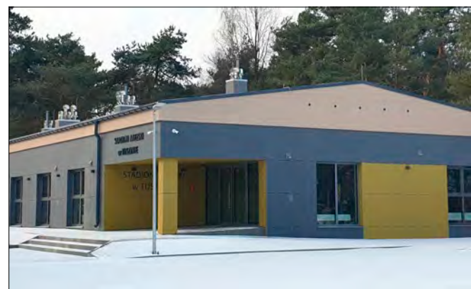
3: Nowy budynek na Stadionie Miejskim
