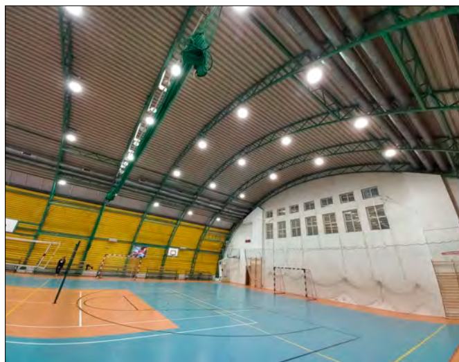
Nowe oświetlenie w Hali Sportowej
