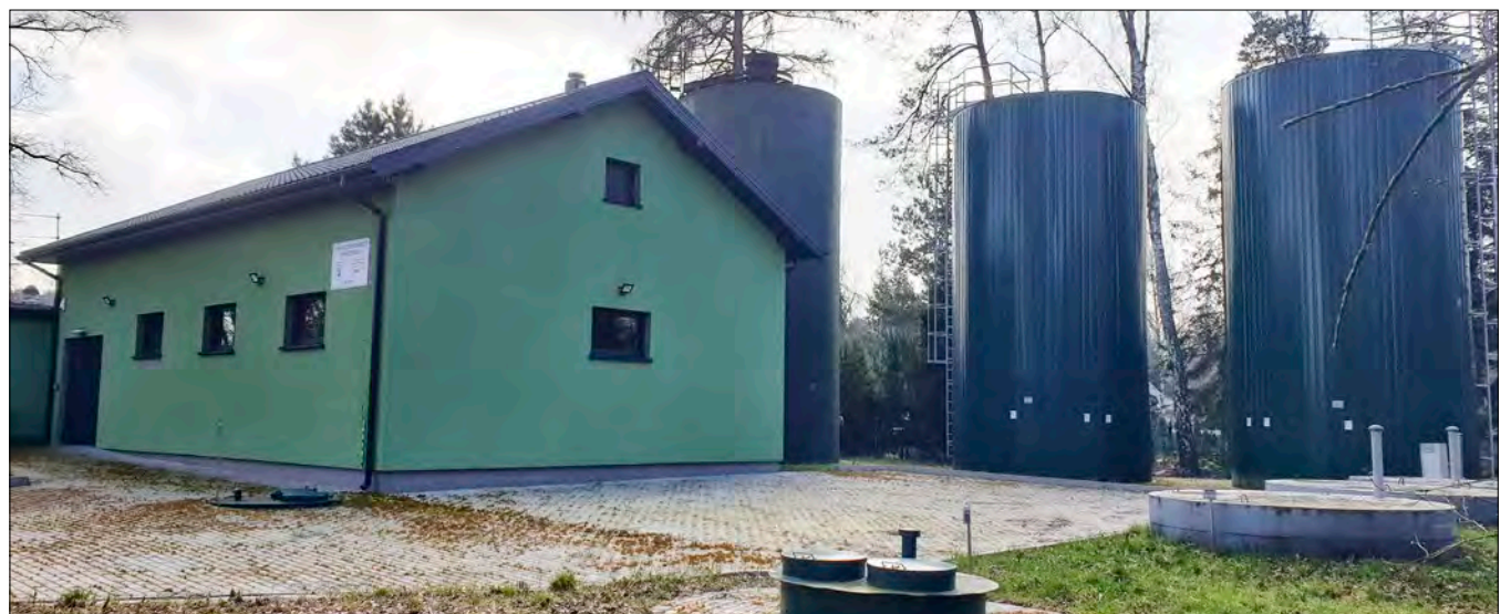
Stacja uzdatniania wody w Rydzynkach.
