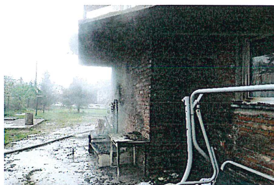
03.05.2020 r. - pożar budynku mieszkalnego w Koluszkach ul. Brzezińska 3 zastępy JRG – 9 strażaków.
